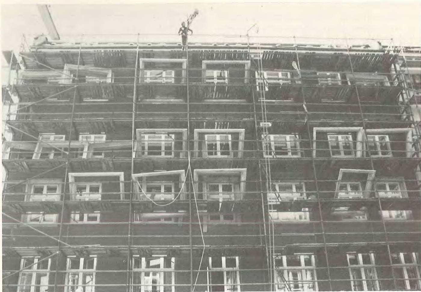
Figur 54. Lysningselementer af Glaton oplagt på stillads, klar til ophængning.
