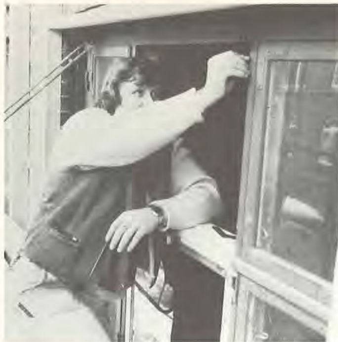
Figur 79. Inden forsatsrammerne blev monteret, erstattedes det faste glas i de store vinduer med en ny tværpost og oplukkelige rammer.
