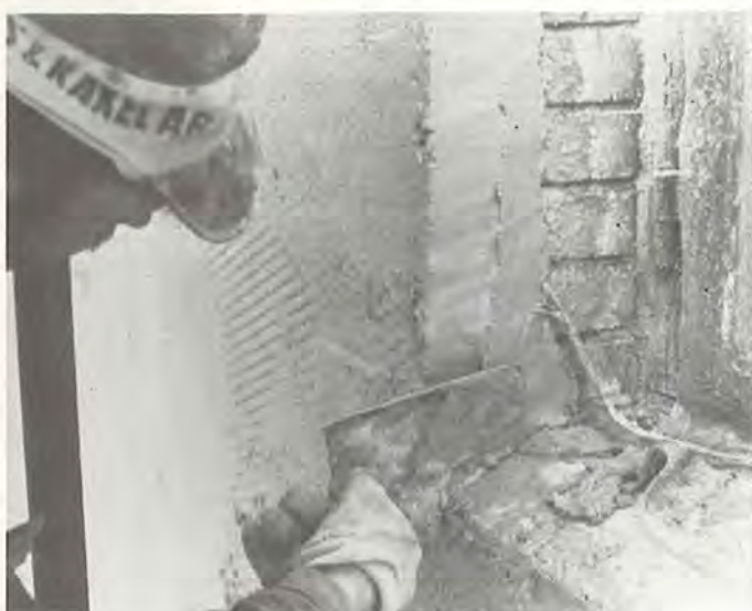
Figur 28. Grundingspudsen jævnes med bræt og murske.
