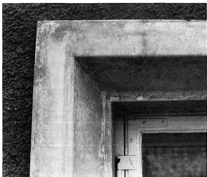
Figur 50. Hjørne af lysningselement, som samtidig danner vinduesindfatning.
