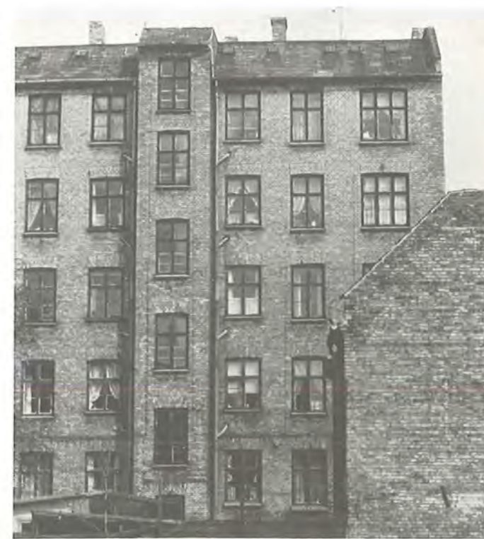
Figur 72. Facade mod gården før isoleringsarbejdet.
