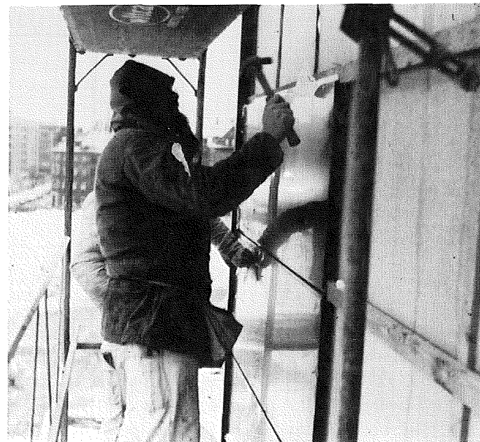
Figur 23. Vandrette brædder pr. 60 cm sømnes i afstandslisterne. Heri fastgøres aluminiumkassetterne med specialskruer.
