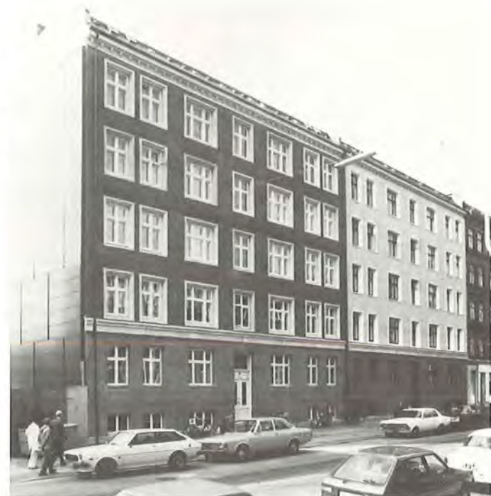
Figur 30. Den færdigisolerede gadefacade.
