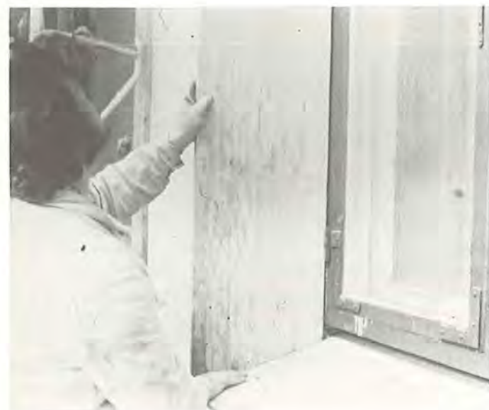
Figur 67. Tilpasning af lysningspanel mod gaden.
