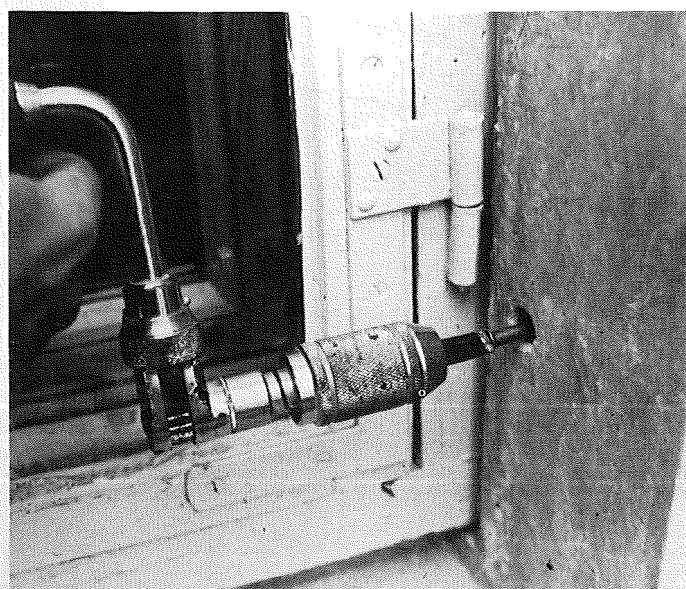
Figur 47. Fastgørelse af lysningselement.
