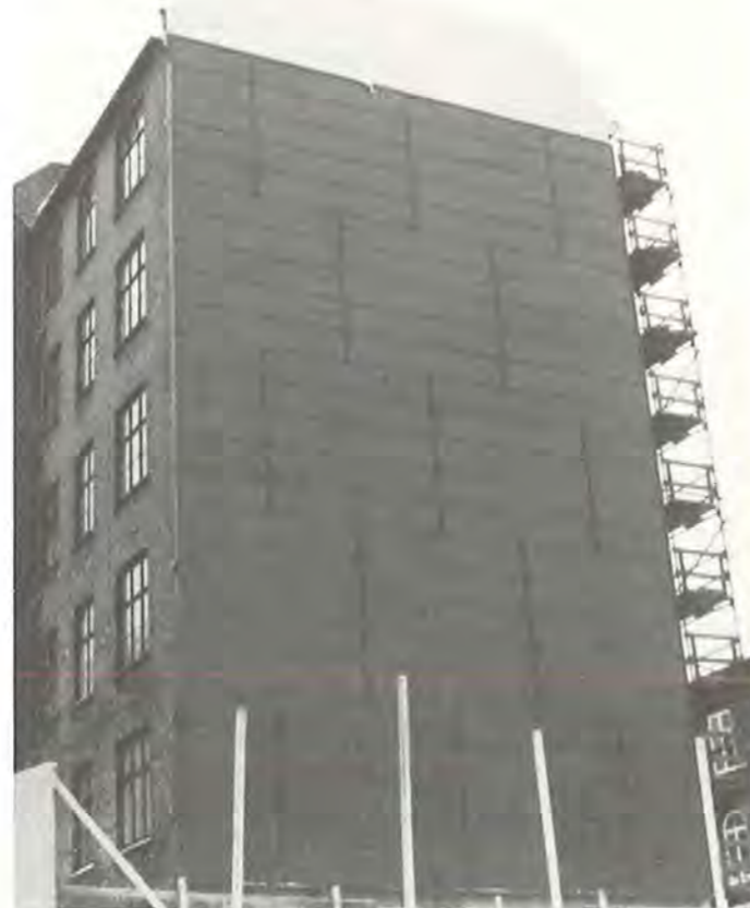
Figur 20. Foto af gavl efter isoleringsarbejdet.
