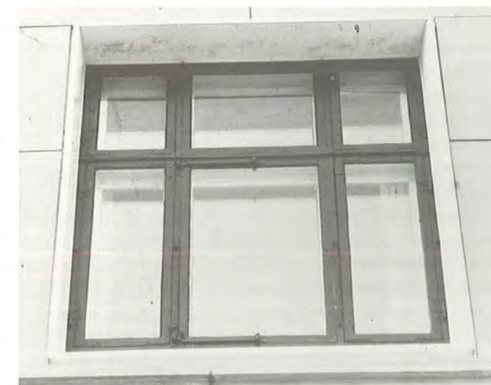
Figur 56. Vindueslysninger mod gaden beklædt med hvid plastbelagt stålplade.
