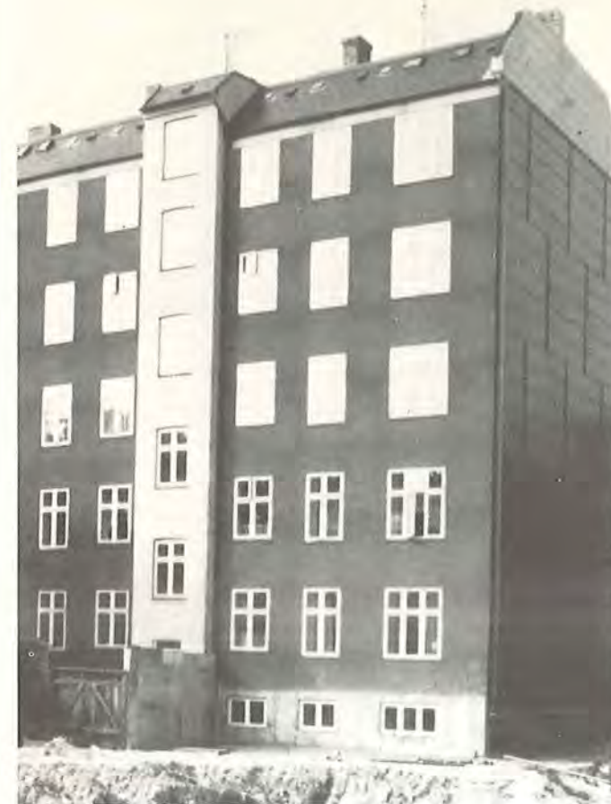
Figur 31. Gårdfacadens trappetårn er uisolert og forned er støbt en 1,5 m høj betonsokkel.
