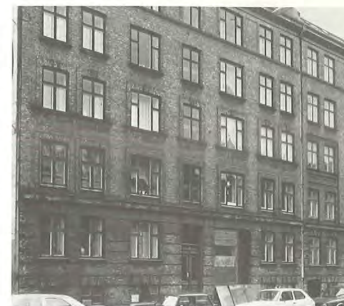
Figur 71. Facade mod gaden før isoleringsarbejdet.
