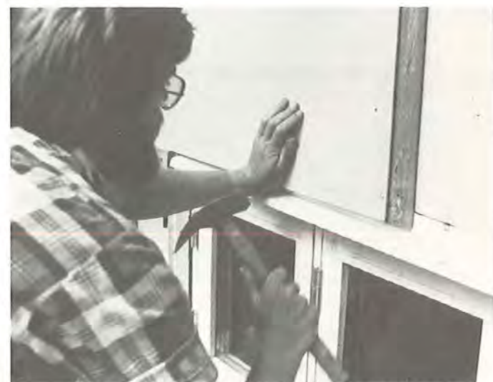
Figur 70. Inddækningen er monteret før Siroc-pladen fastgøres.
