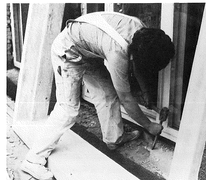
Figur 53. Tilhugning af murhul for montage af lysningselement.
