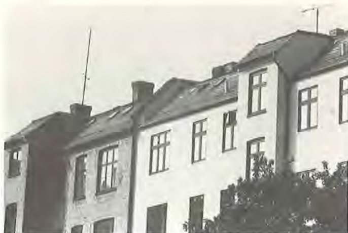
Figur 57. Siroc-facadebeklædning mod gården.
