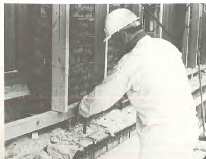
Figur 68. Tilpasning af gesimsen over stueetagen.
