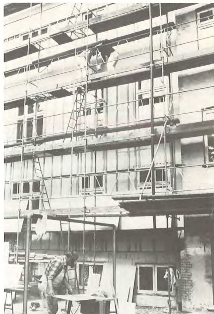
Figur 69. Opsætning af Siroc-plader.
