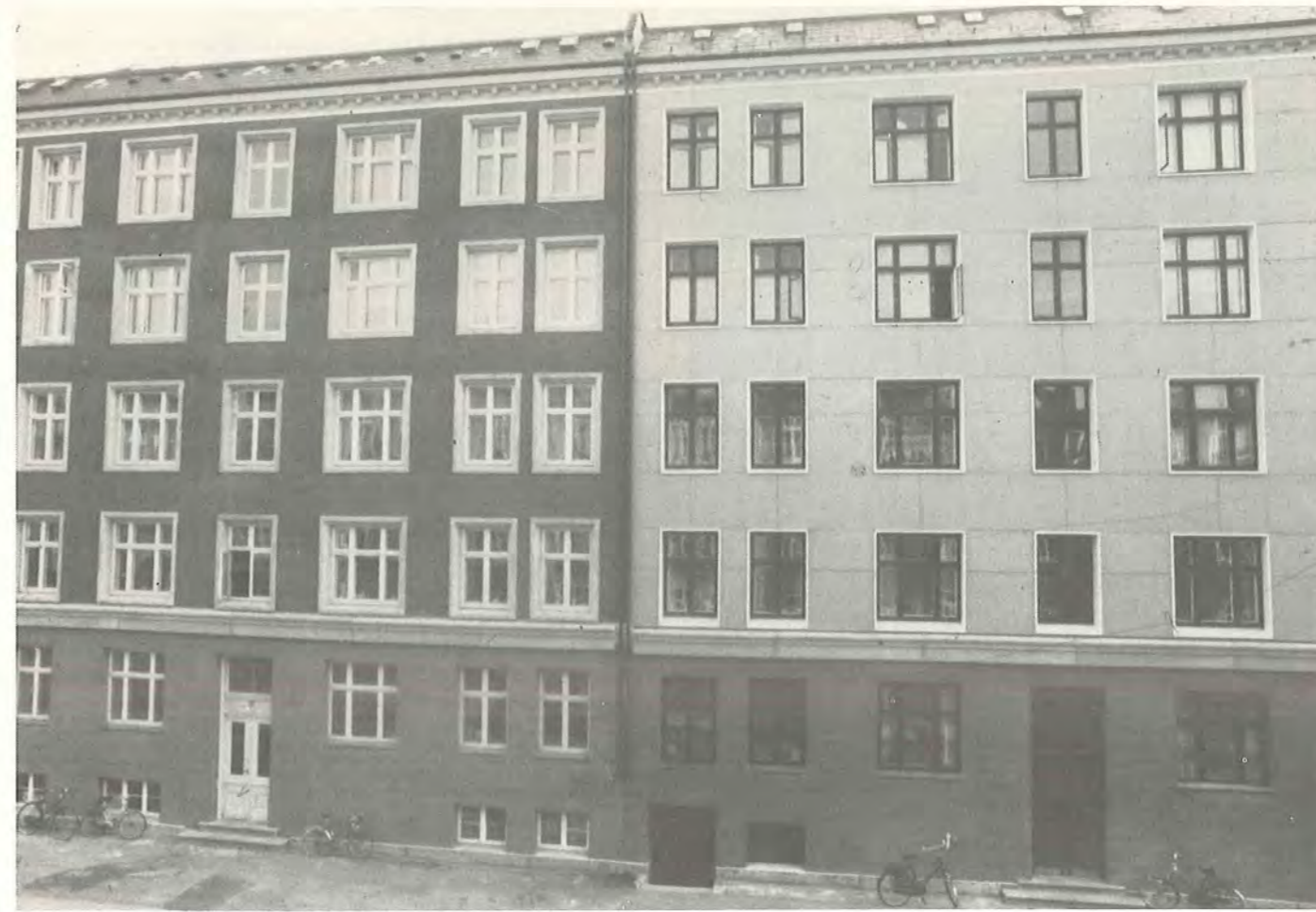
Figur 55. Færdig isoleret facade mod Niels Ebbesens Vej.
